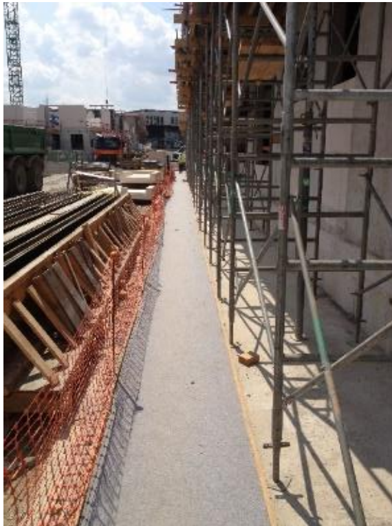
Figuur 32:afbakening looppaden op een bouwwerf
