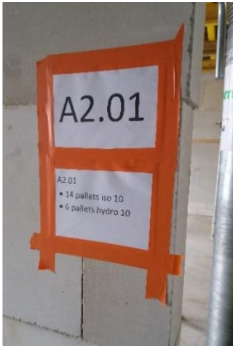
Figuur 43: stockageplaatsen bij afbouw
